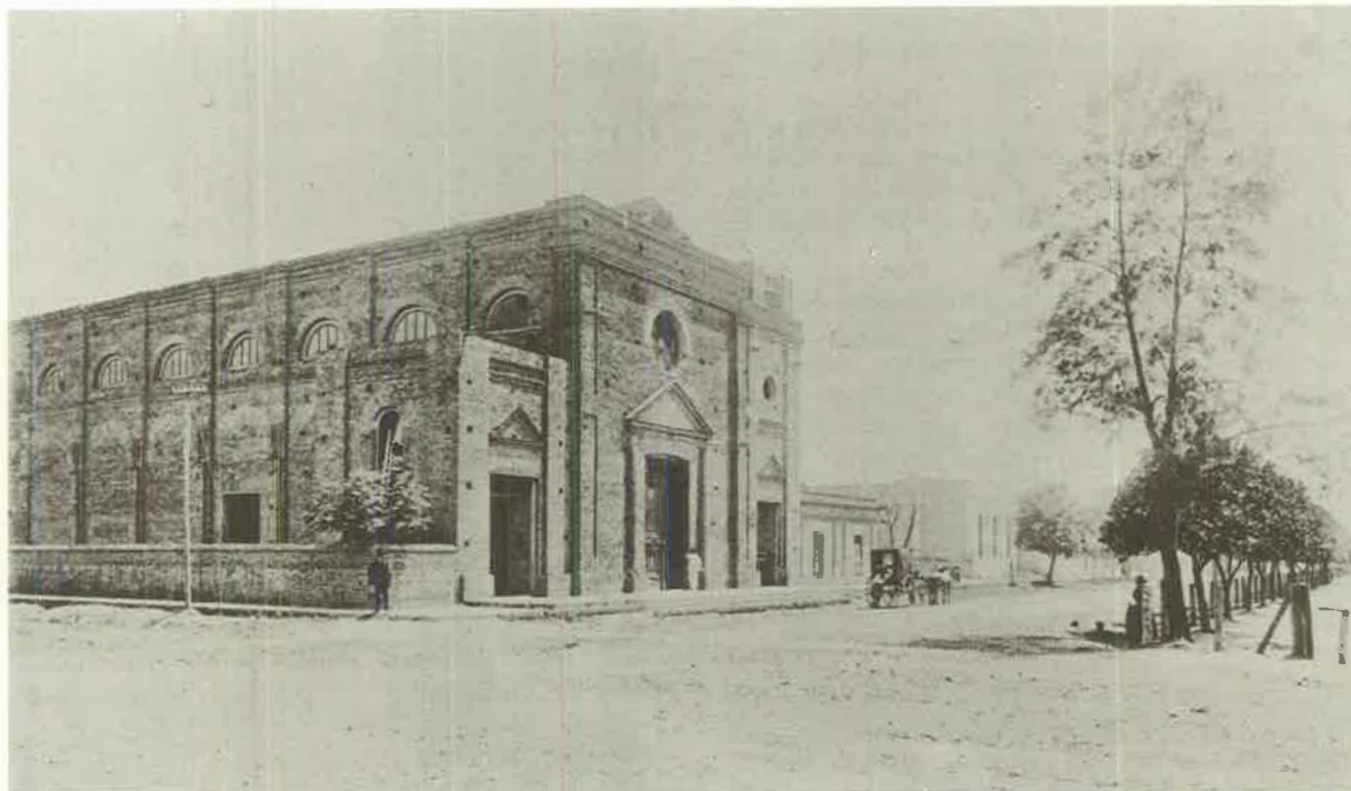
La iglesia de Resistencia y parte de la plaza principal, a fines del siglo pasado (gentileza de R. Gutiérrez).
