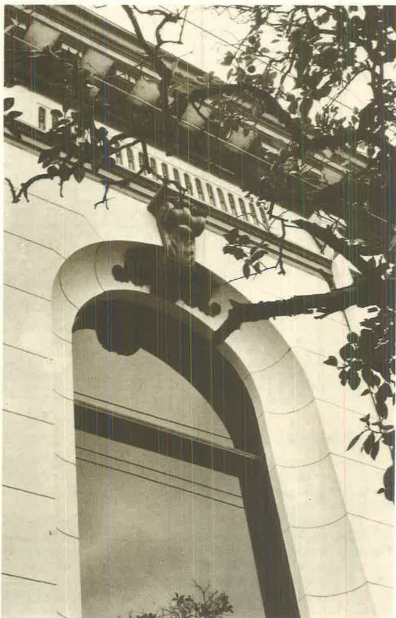
Detalle de ventana sobre la calle Belgrano con el nuevo cerramiento (foto M. Silva).
