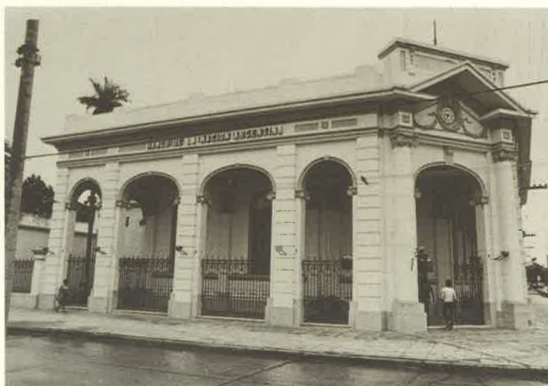
Vista de la fachada lateral sobre la calle Salta (foto L. Peso).
