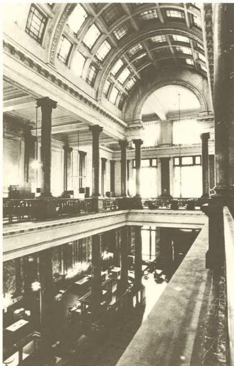
Vista interior de la nave del Anexo, desde planta alta (foto BNA, Archivo Sub. Arq.).
