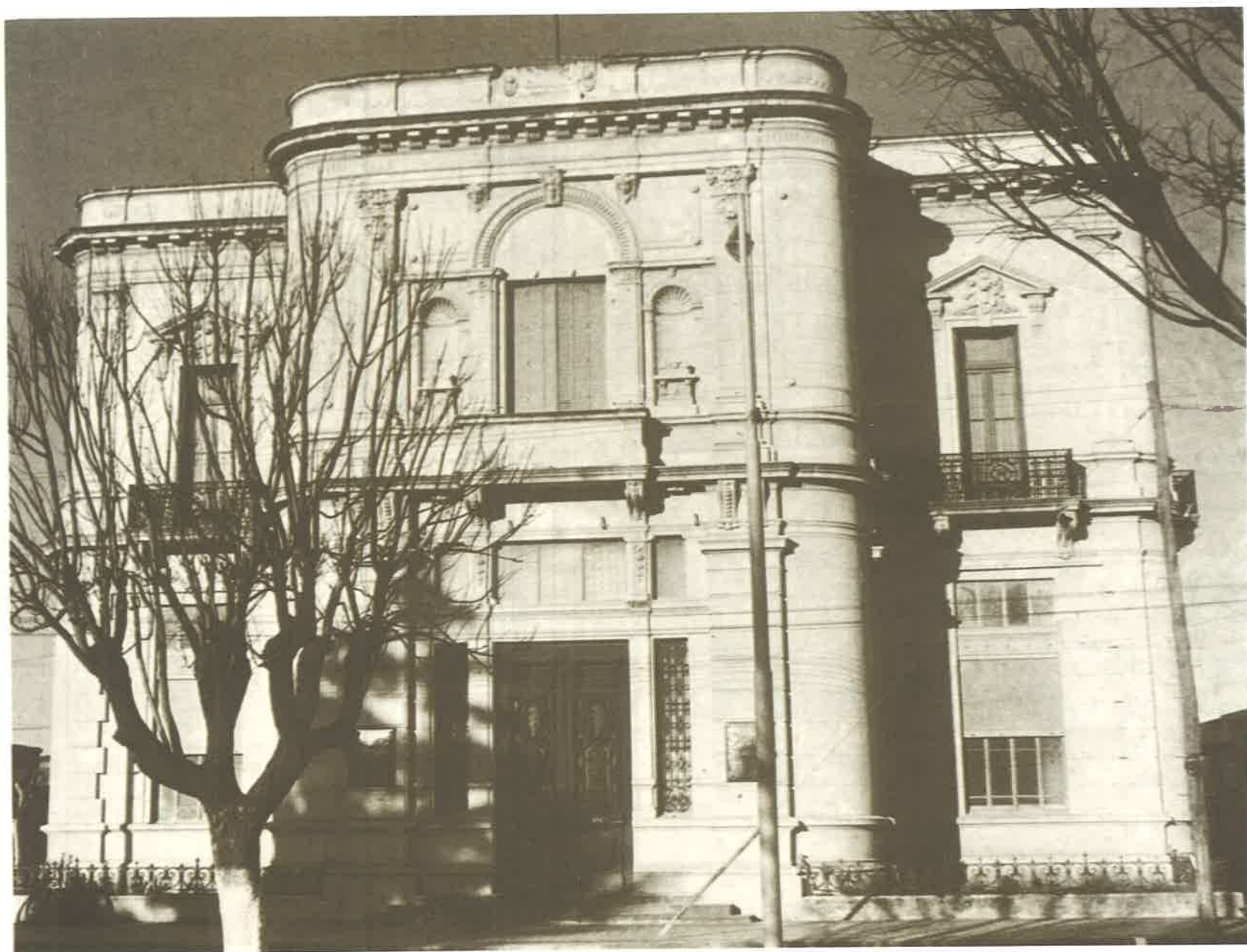
El edificio con su ornamentación ya modificada (foto BNA, Archivo Sub. Arq.).
