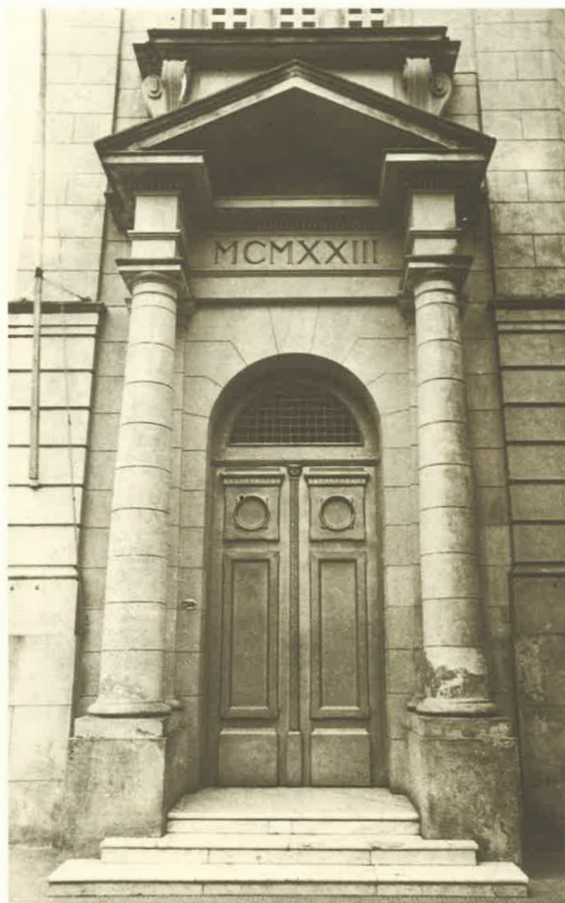
Pórtico del ingreso principal en ochava (foto R. Alvarez).
