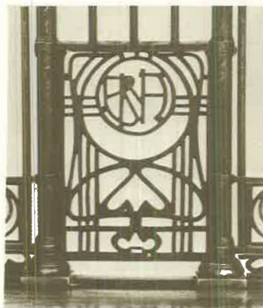
Artefactos de iluminación interior del edificio y detalle de reja de caja con logotipo del Banco de la Nación Argentina (foto R. Alvarez).
