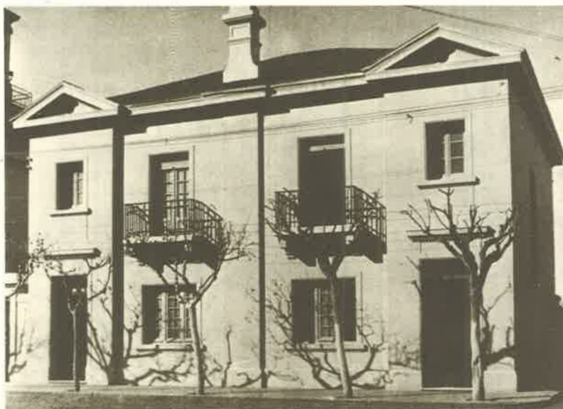
En la foto superior, la vivienda del gerente. En la foto inferior, las viviendas destinadas al contador y tesorero; a la derecha de las mismas, el típico callejón derivado del urbanismo inglés (fotos BNA, Archivo Sub. Arq.).
