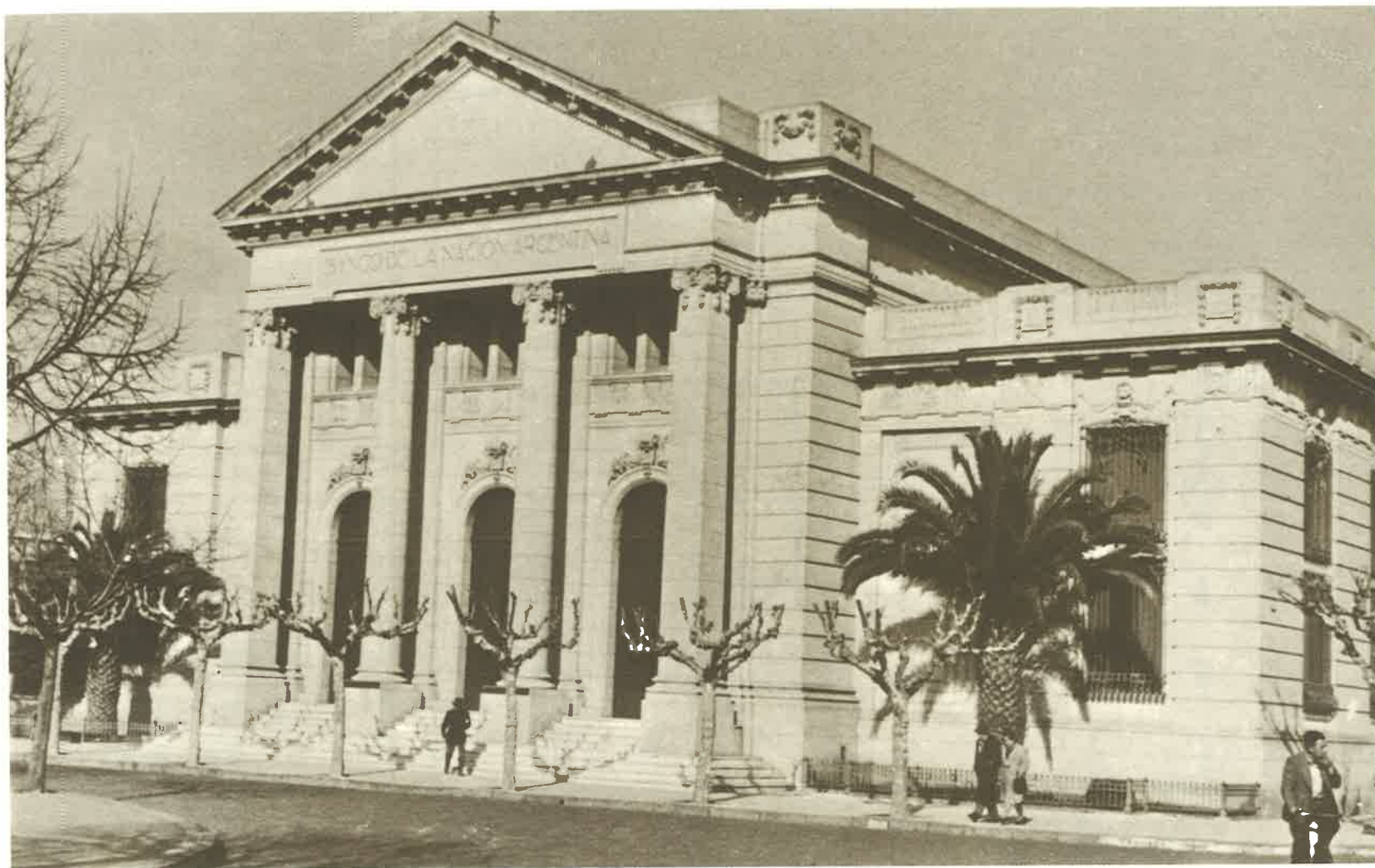
Vista del edificio frente a la plaza 25 de Mayo hacia 1950 (foto BNA, archivo Sub. Arq.).
