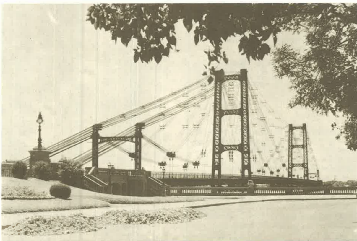
Vista general del puente colgante (foto AGRN).
