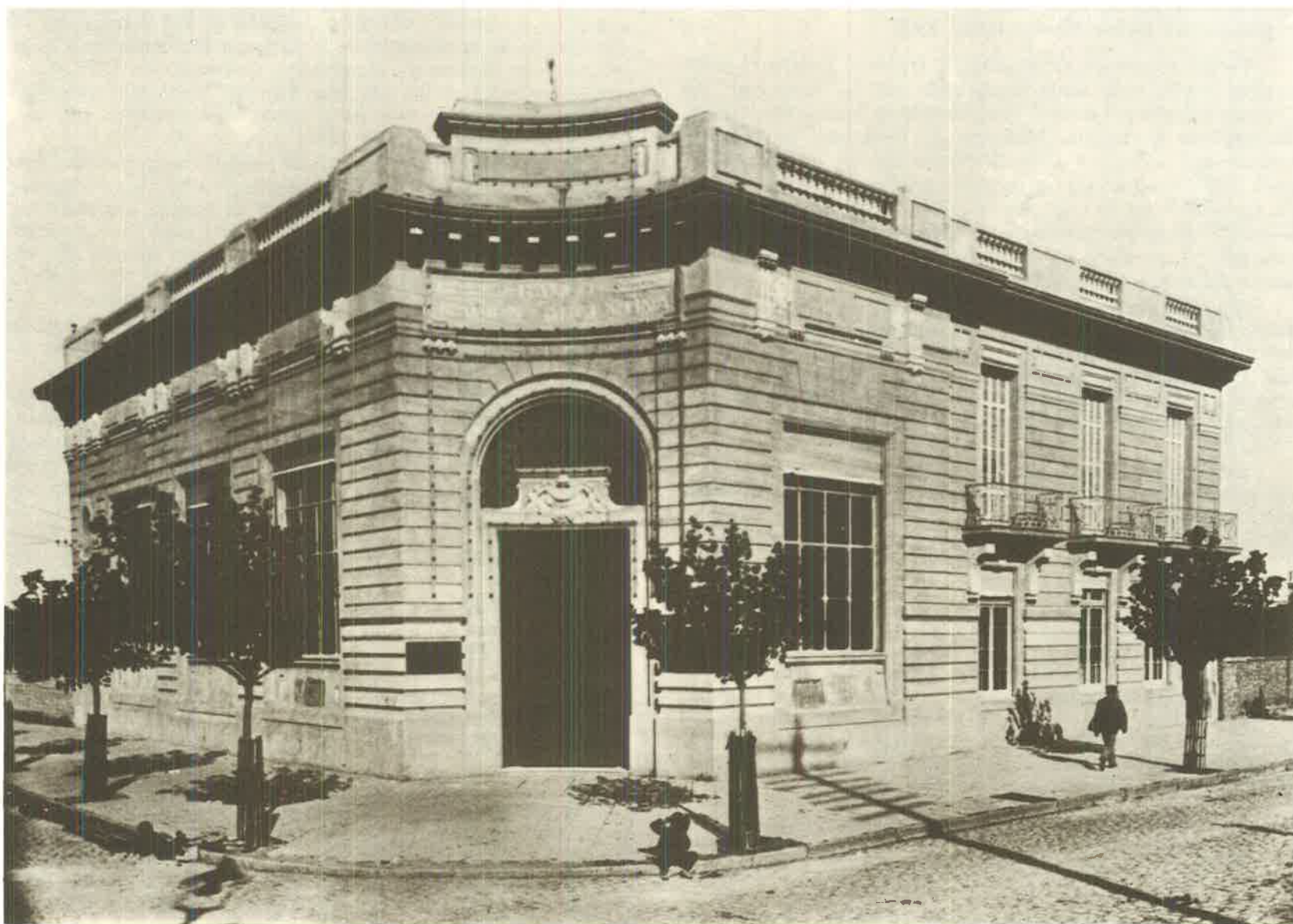
Antigua sede de la Sucursal en el edificio proyectado por el arquitecto Christophersen, hoy Aduana (BNA, Album Museo).
