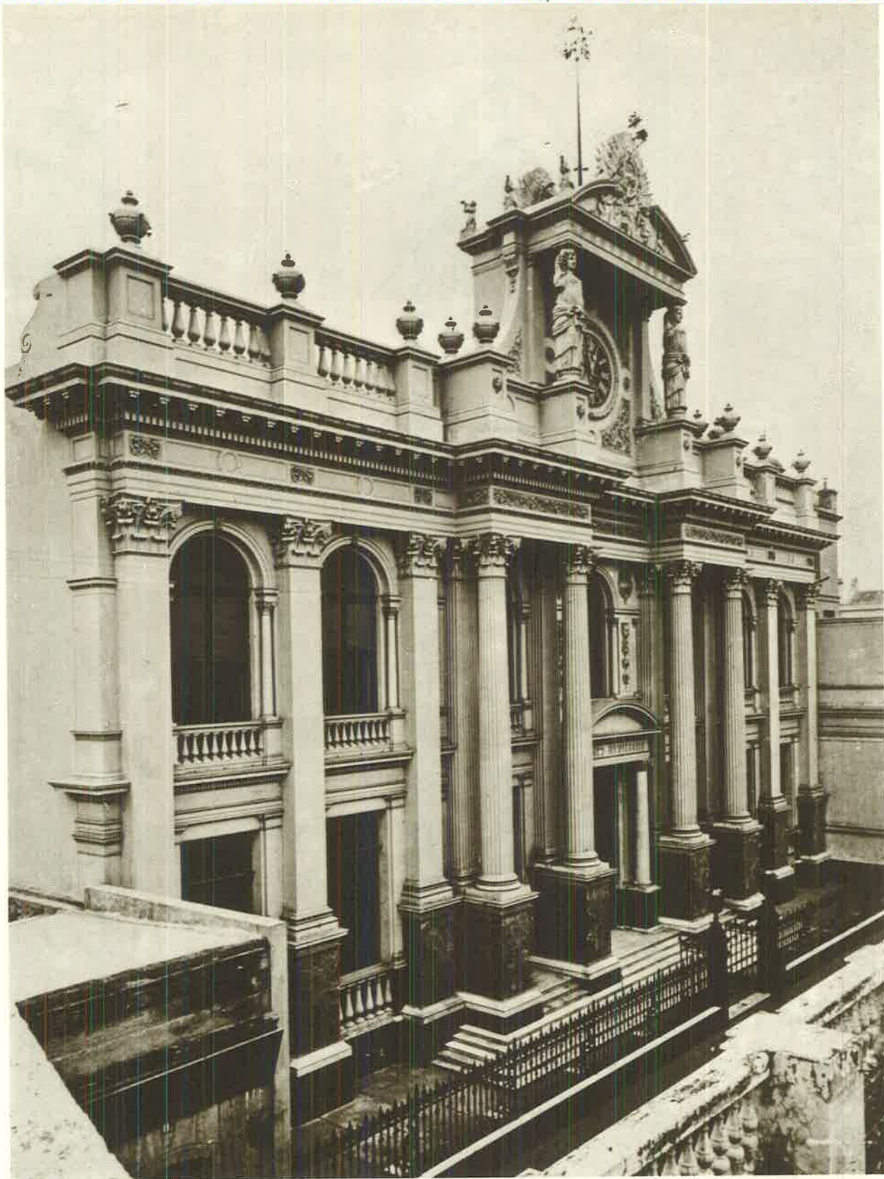
Sede Matriz en la Capital Federal del Banco Hipotecario de la Provincia de Buenos Aires, hoy sede del Banco Central de la República Argentina, construido entre 1872 y 1876 (autor: Hunt y Schroeder, foto AGRN).
