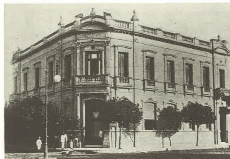
Otro de los edificios ocupados por el Banco en Resistencia (BNA, Memoria 1929).
