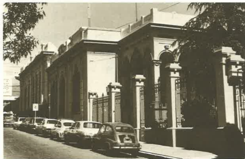
Fachada lateral sobre la calle San Martín, donde también puede apreciarse la vivienda del Gerente (foto M. Silva).
